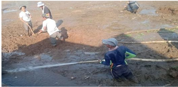
Gambar 1. Warga Desa Sukamekar bergotong royong membersihkan dan menggali sedimen lumpur serta membersihkan ganggang Situ Cijeruk
